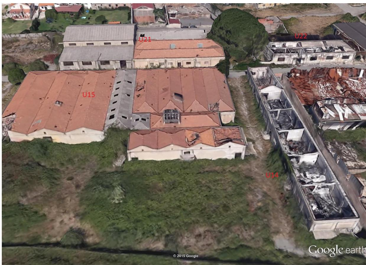
La copertura del magazzino generale U14 appare completamente crollata con sfabbricidi contenenti amianto sparsi al suolo all'interno dell'edificio, per una superficie di circa 1.000 m<sup>2</sup>
